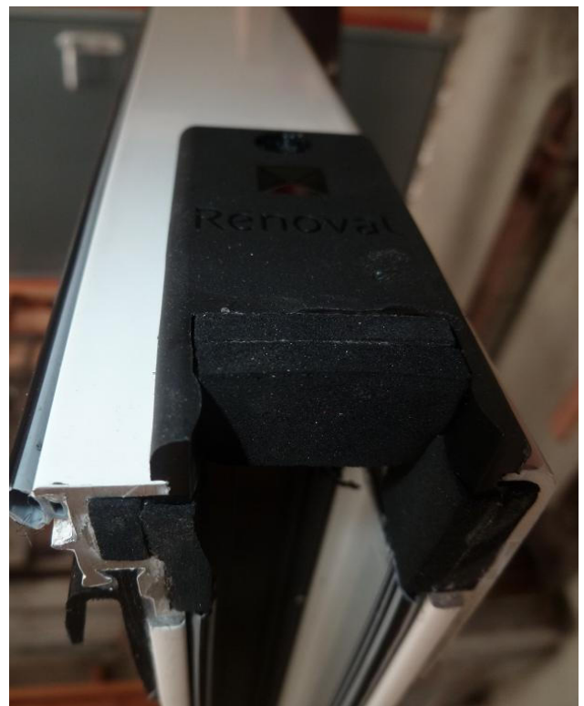
Etanchéité sur chicane centrale en partie haute et basse
