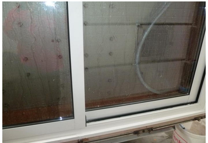
Essai d'étanchéité à l'eau
