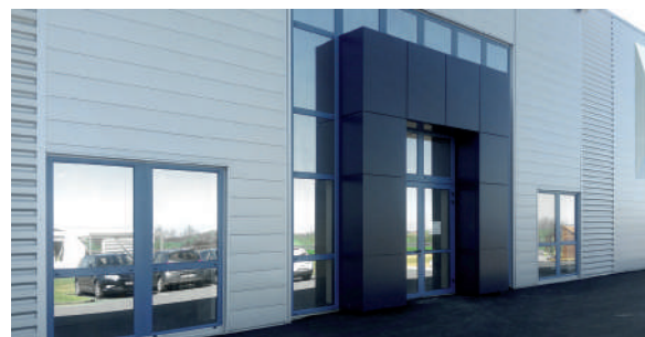
Assemblage de châssis + porte
