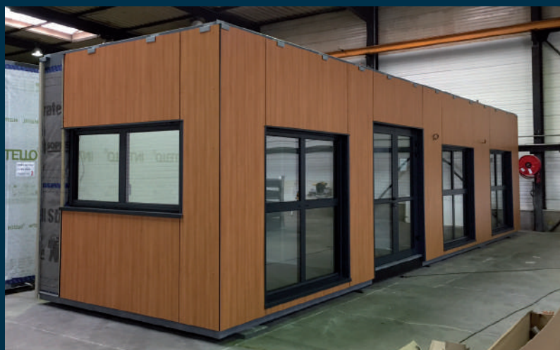
Pose par clipsage sur construction modulaire : oscillants-battants + portes
