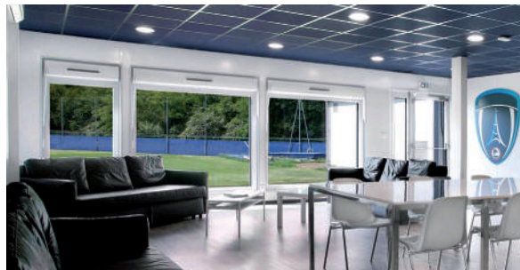
Châssis fixes + volets roulants
